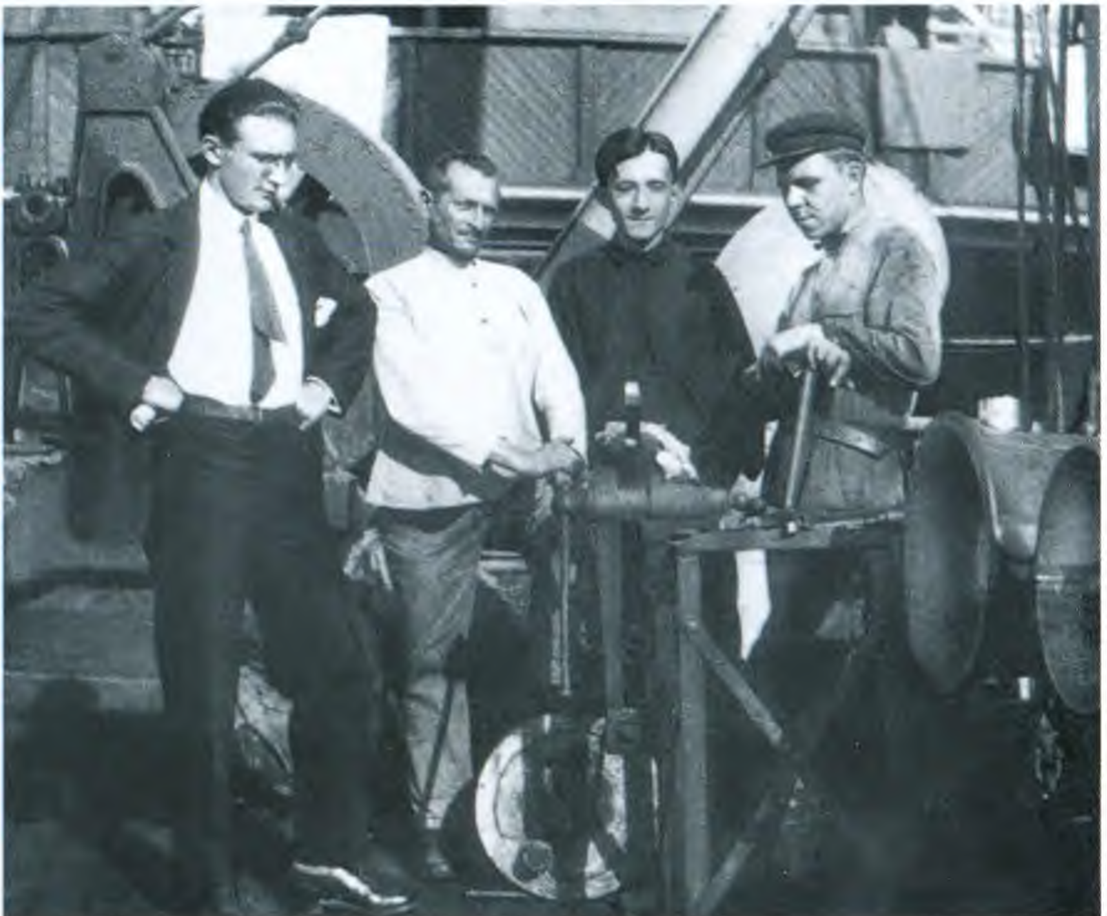
Русские рабочие в ремонтных мастерских трамвайного депо. Париж. 1930-е гг.
